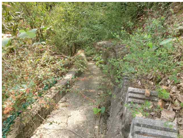
산마루측구, 점검계단 전경
